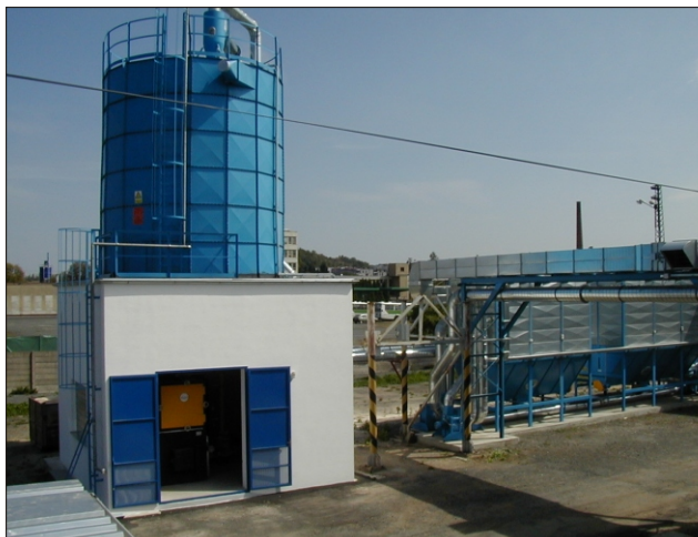
• Silos na paliwo drzewne nad kotłownią - ZP 5000 (wys. 6 m) w firmie TVAR v.d. (Klatovy, ČR)
