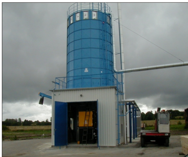
• Silos na paliwo drzewne nad kotłownią - ZP 5000 (výška 8 m) w firmie Pila Vrátó a.s. (České Budějovice, ČR)
